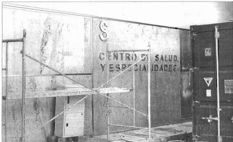
El cartel de 'Centro de Salud y Especialidades' ya está colgado del edificio.
